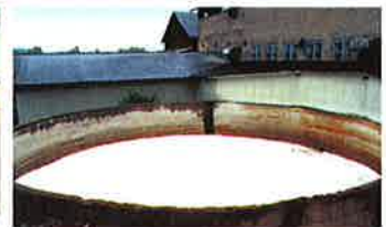
EKOKIDE on asettunut säiliön pinnalle. Kate on valmis.
